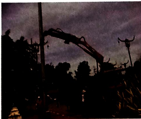
รูปที่ 1.22 เครื่องมือย้ายเสาและยกเสา
