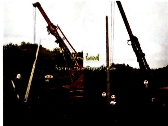
รูปที่ 1.22 เครื่องมือย้ายเสาและยกเสา
